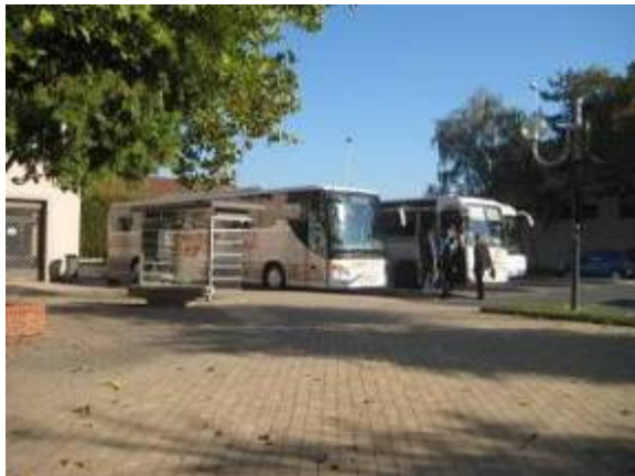
La gare routière actuelle - EGIS - 2010
